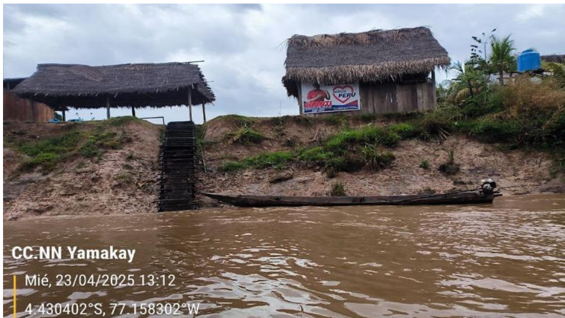
FIGURA N°02: ESCALERA PEATONAL EXPUESTA A LA EROSIÓN FLUVIAL
